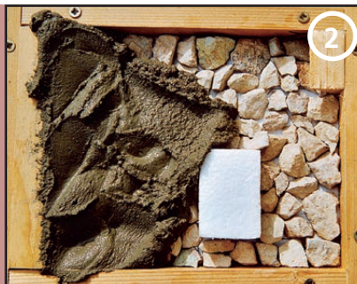
1 Aus einem Holzrahmen, Steinen und zähem Beton werden die Wände gefertigt. Styroporklötze oder Schrauben markieren die späteren Öffnungen.
